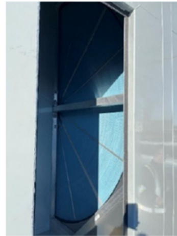
Figure 2b : Roue interne d'aluminium.
